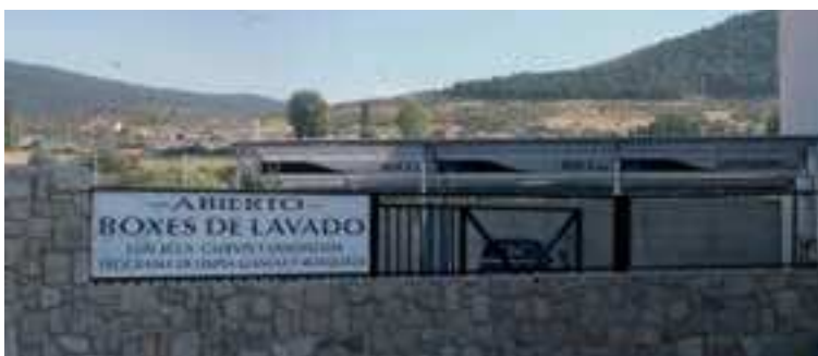
La entrada a la zona de lavado está perfectamente señalizada.
