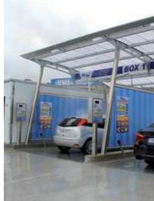
El cerramiento en acero inoxidable pulido espejo facilita la limpieza y el mantenimiento de la estructura y confiere a la instalación "un aspecto más atractivo"
